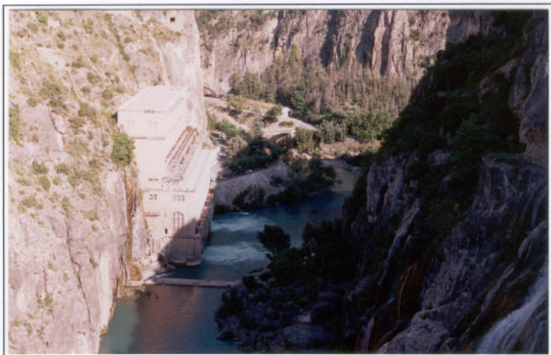
Río Noguera Pallaresa, inmediatamente aguas abajo de la presa de Camarasa. Se observa el desagüe del agua turbinada en la central hidroeléctrica situada a pie de presa.
