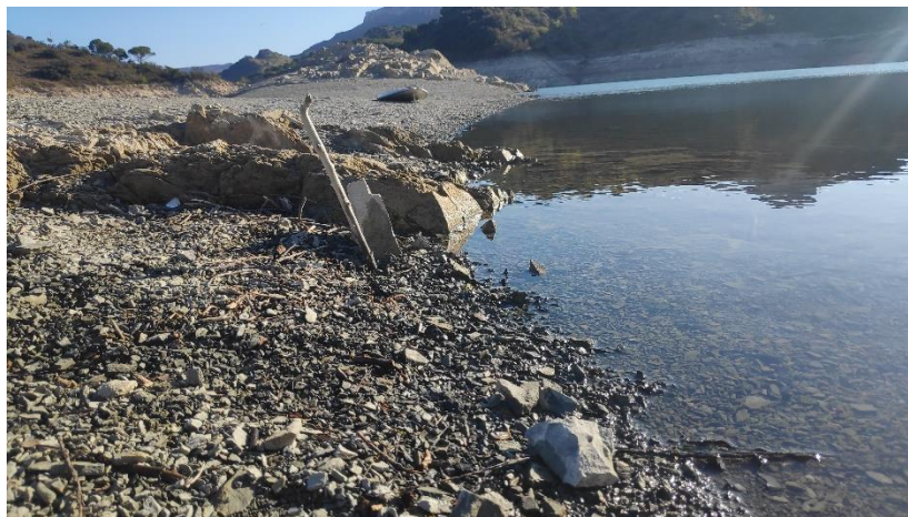
Figura 112 Zona de orilla del embalse de Ciurana
