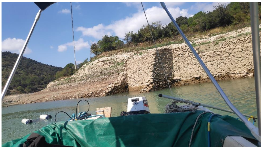
Figura 51 Sistema remolcado trabajando en la zona
