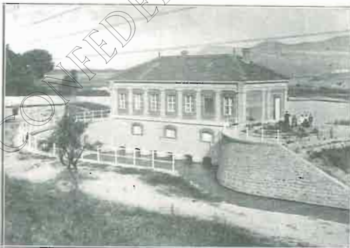
Casa de compuertas, año 1918
