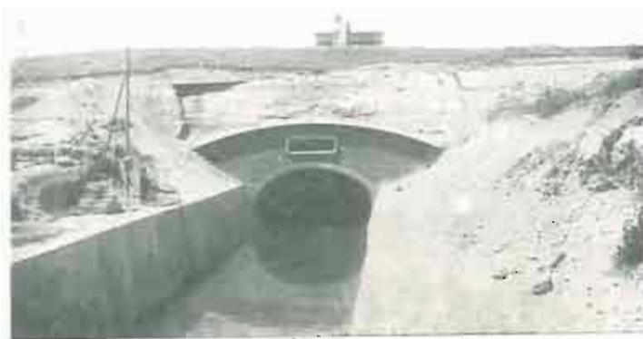
PANTANO DE LA SOTONERA. — Túnel de toma inferior
