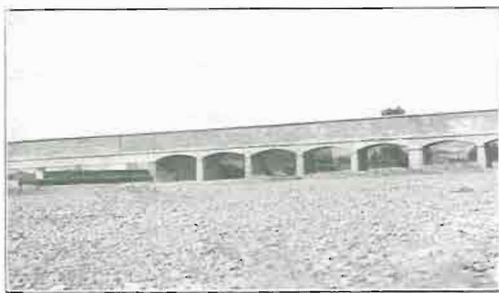
Acueducto del Cidacos, terminado. Vista parcial, 1923
