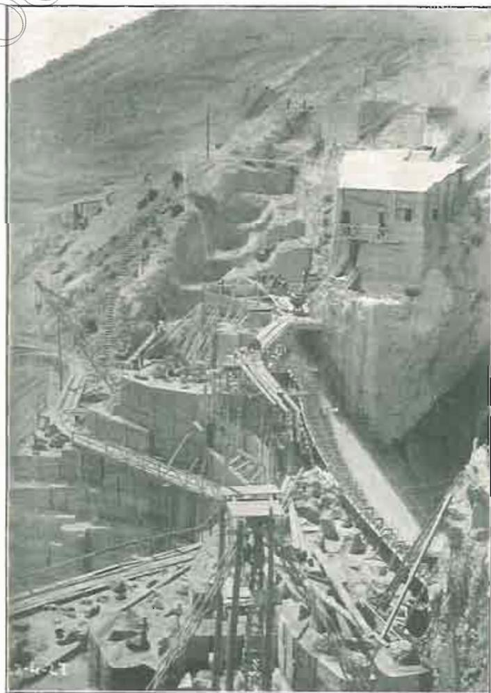
Detalle de la construcción de la presa, con la instalación de hormigoneras.
