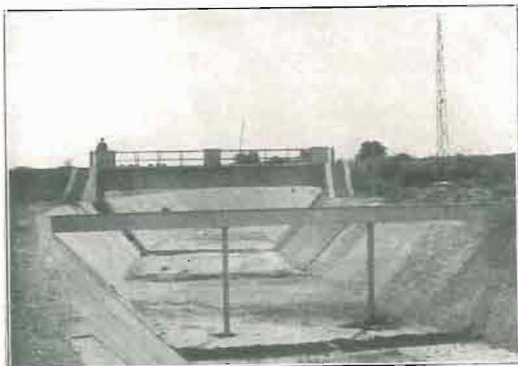
Paso sobre el Canal de una acequia de riego y en segundo término de la conducción de aguas para la Azucarera de Calahorra, (Sección I)
