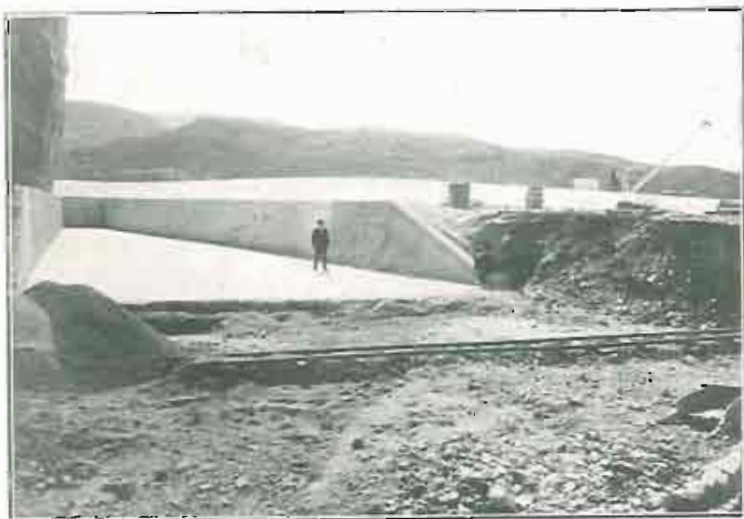
Aliviadero de superficie
