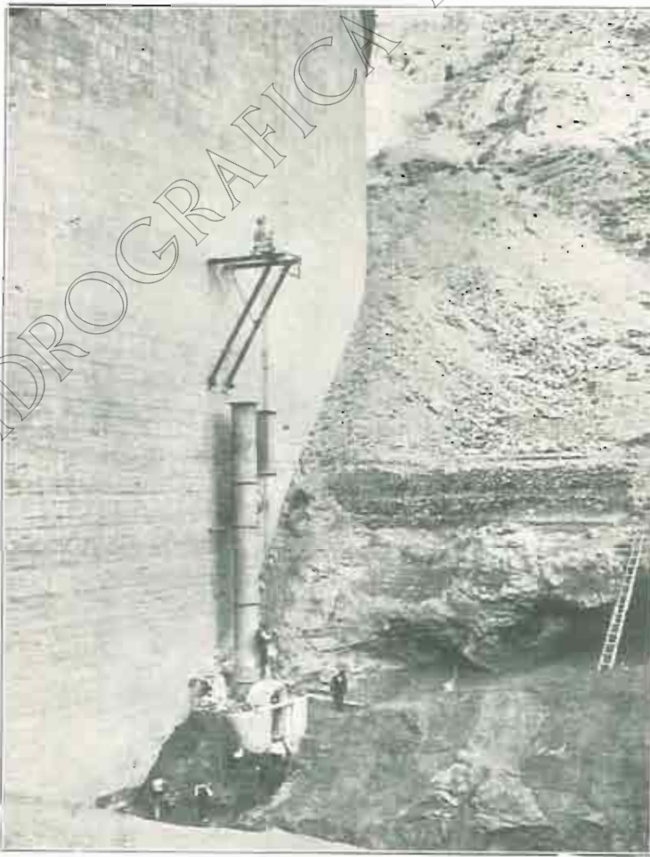
Colocación de las compuertas en el Pantano de Barasona
