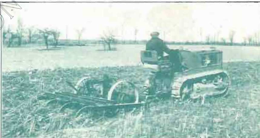
"CATERPILLAR", 2 TONELADAS CON CULTIVADOR-ESCARIFICADOR "KILLER", DE 1.50 M. DE ANCHO
