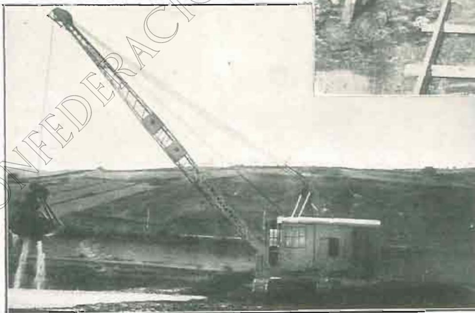
Excavadora "Northwest" empleada en las obras.
