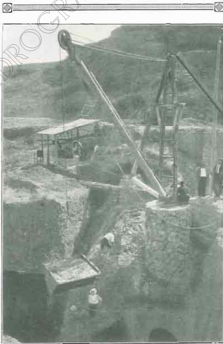
PANTANO DE MONEVA. Cimientos aguas abajo de la presa, para la ataguía de desviación de las aguas de riego.
