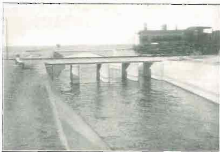
CANAL VICTORIA ALFONSO: Pazo del rápido sobre un puente del Canal.
