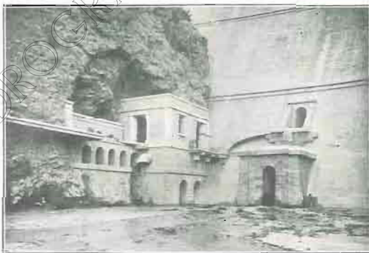
PANTANO DE CUEVA FORADADA. Detalle: del desagüe de fondo, para riego.
