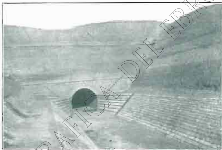
Boca de entrada al túnel de Alfaro.
