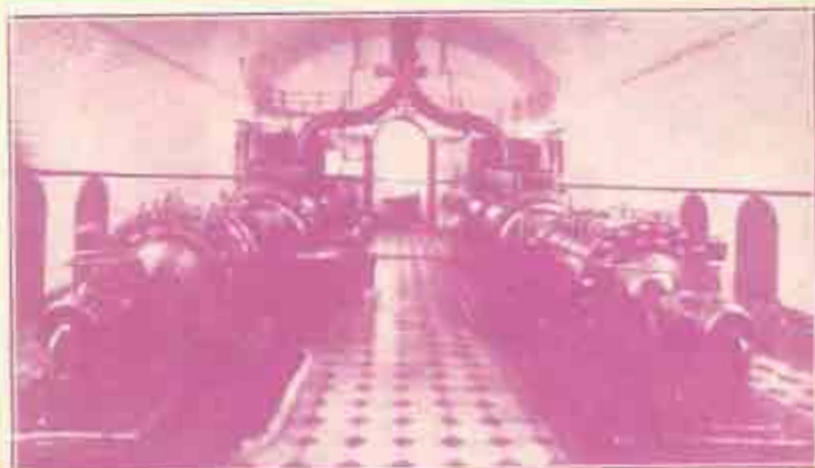
INSTALACIÓN DE LA MINA "ARRAYANES" (JAÉN) CUATRO GRUPOS DE BOMBAS 41 litros por segundo, 325 metros altura elevación, 500 HP. cada grupo; instalación de bombas centrífugas más importante de España.
