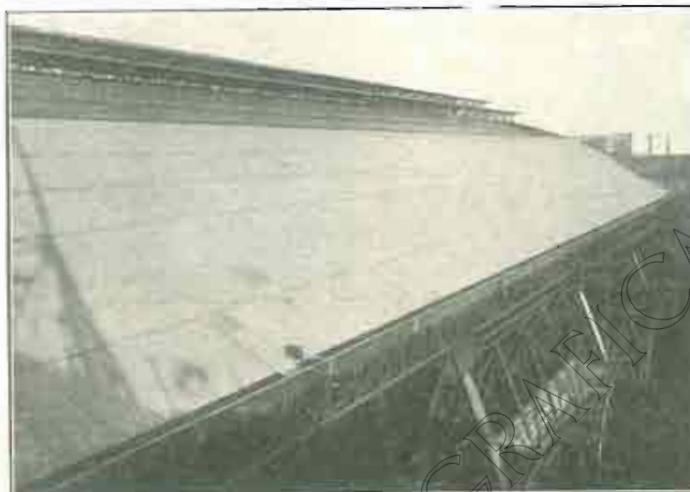
Cortes de la nueva instalación de M. S. A. de Barcelona, techada con placas CANILETA
