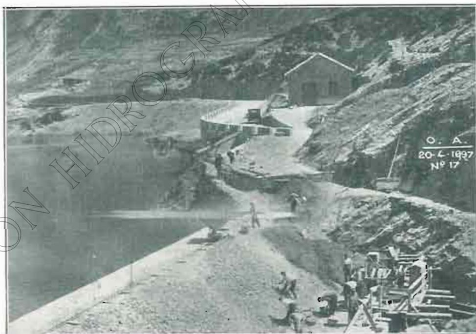
PANTANO DE ARGUÍS: Aspecto de las obras de recrecimiento de la presa.
