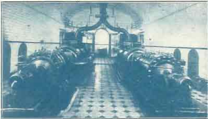
INSTALACION DE LA MINA "ARRAYANES" (JAEN) CUATRO GRUPOS DE BOMBAS 45 litros por segundo, 225 metros altura elevación, 300 HP, cada grupo. Instalación de bombas centrífugas más importante de España.
