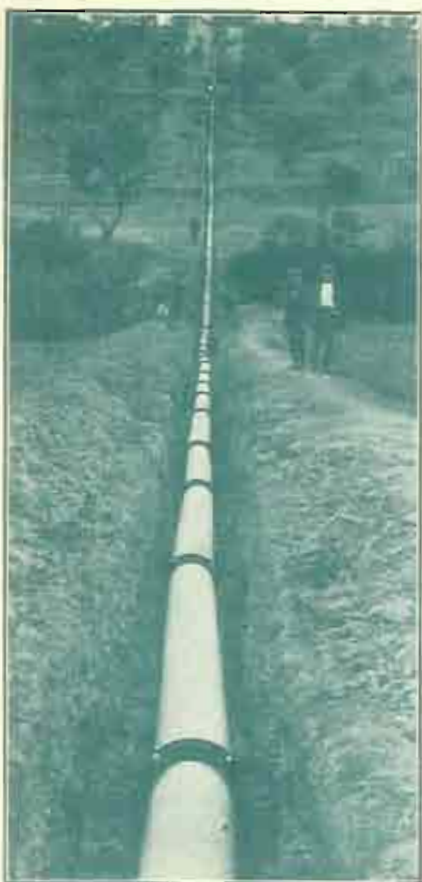
CONDUCCIÓN DE AGUAS EN CERVERA (Lérida) 1055 metros longitud. - 250 m/m diámetro. - 10 atmósferas
