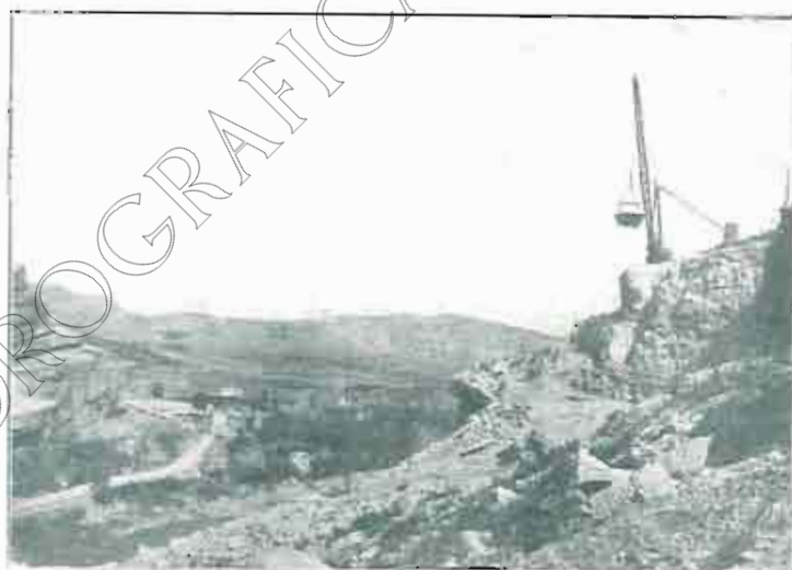
PANTANO DE SANTOLEA: Desmante para la torre y cámaras de la galería exterior a la presa.
