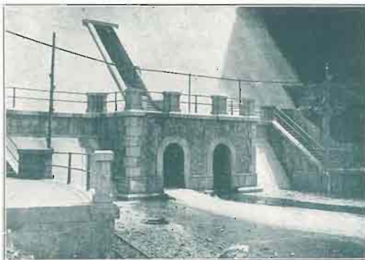
SALIDA DEL AGUA POR LA GALERÍA DE DESAGÜE DE LA PRESA AL EMPEZARSE A ABRIR LAS COMPUERTAS DE FONDO. (Fot. Confederación)
