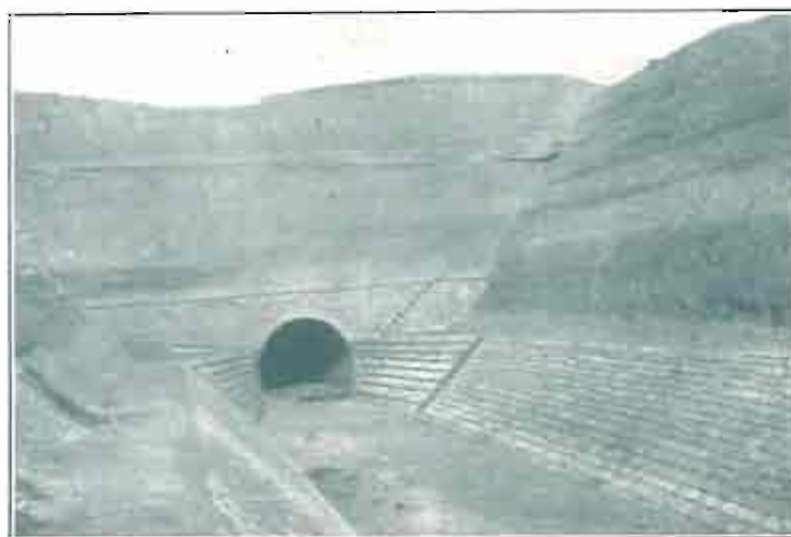
Canal Victoria-Alfonso: boca de entrada al túnel de Alfaro
