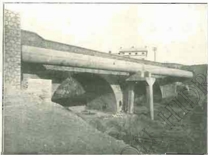
Dos tramos de 17 m. Diámetro interior 1'25 m.
