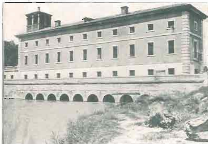
CANAL IMPERIAL DE ARAGÓN: EXTERIOR DE LA CASA DE PUERCAS Y TOMA DE AGUA
