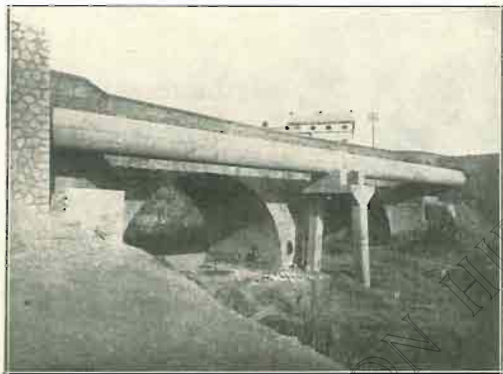
Dos tramos de 17 metros. Diámetro interior 1,25 metros.
