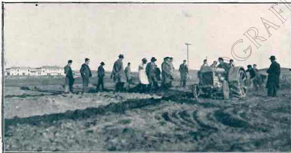
EQUIPO DE NIVELACIÓN FORDSON VIGATA. EL TRACTOR LLEVA GASIPENSOR VELÁZQUEZ QUE PERMITE UTILIZAR ACEITE PESADO EN VEZ DE GASOLINA
