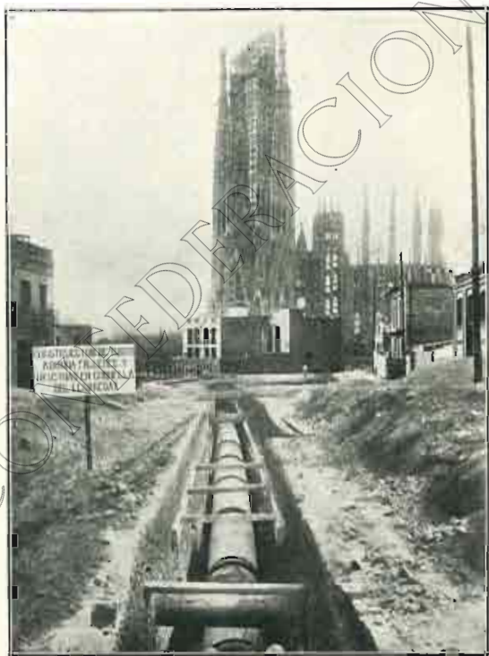
Tubería de 1,00 m' de diámetro.
