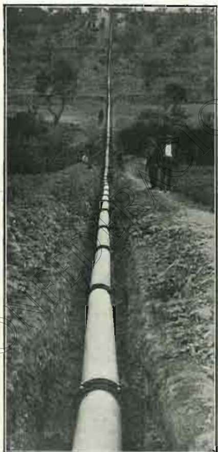
CONDUCCIÓN DE AGUA EN CERVERA (Lérida) 1065 metros longitud - 250 - m/m diámetro 10 - atmósferas
