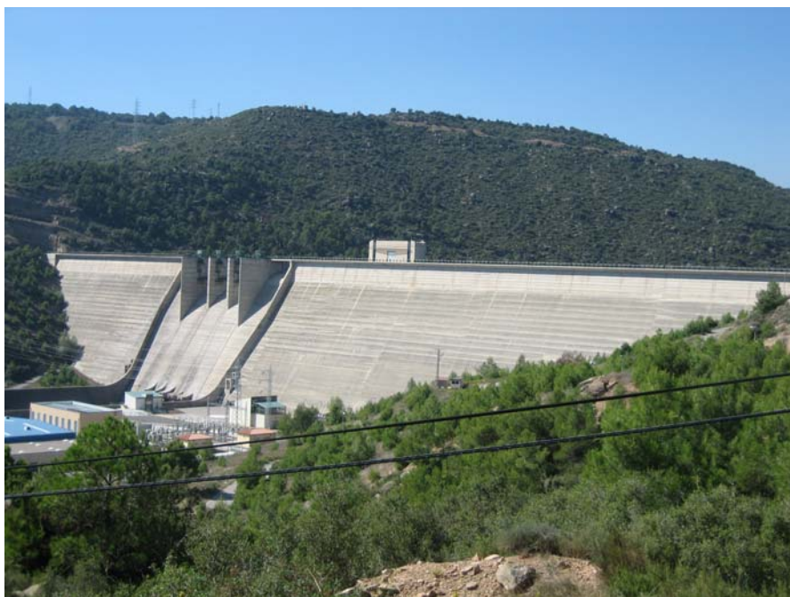
Foto 1: Vista general de la presa del embalse
