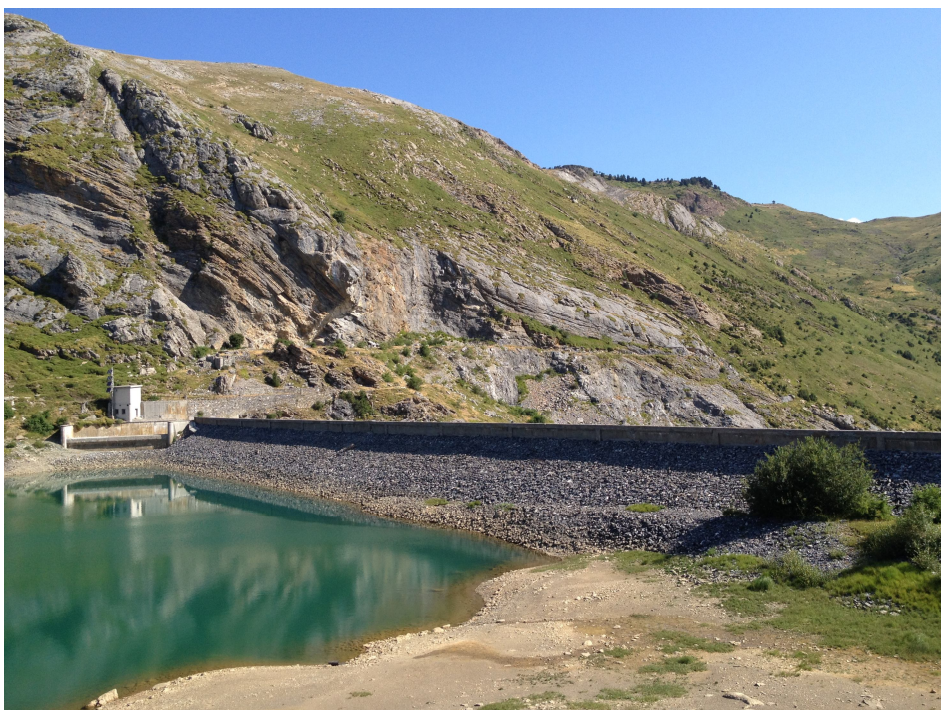
Figura 7. Vista del punto de acceso.
