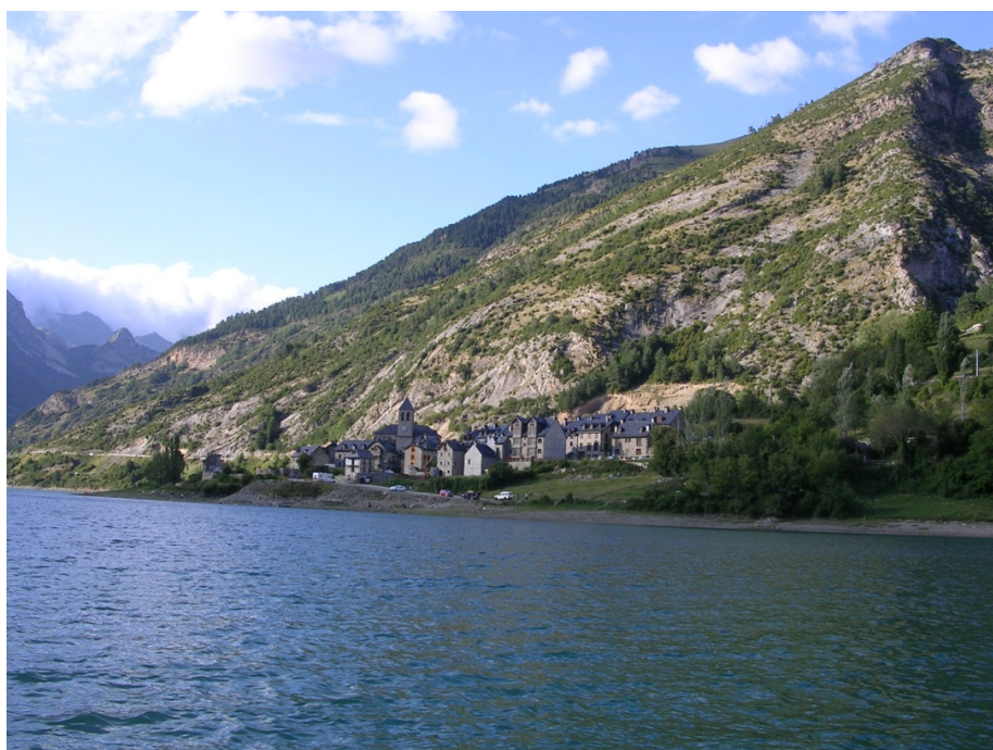
Figura 8. Vista del punto de acceso
