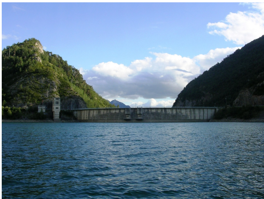
Figura 7. Vista de la presa del embalse
