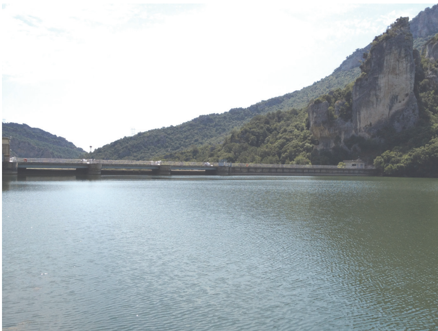
Figura 7: Presa del embalse
