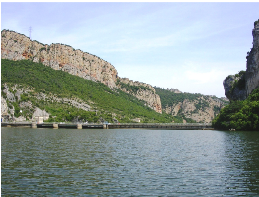
Figura 7. Vista de la presa del embalse
