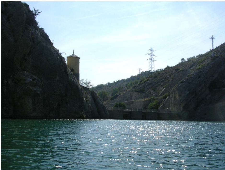
Figura 6. Vista de la presa del embalse
