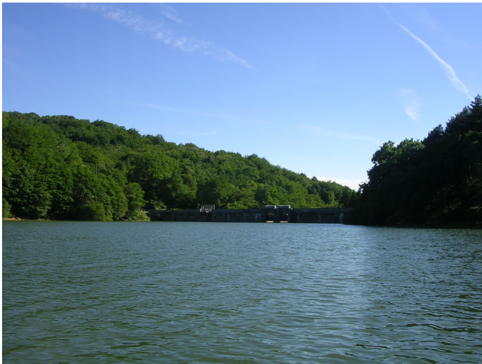
Figura 6. Vista de la presa del embalse.
