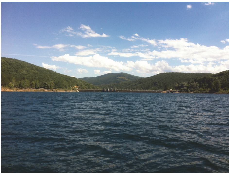
Figura 7. Vista de la presa del embalse
